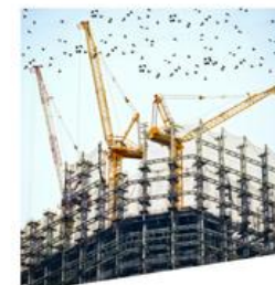
bâtiment et travaux publics
